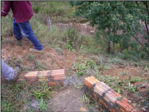
**Figura 33** – Canaletas e dissipadores hidráulicos instalados em 2002, que ainda se encontram em razoável estado de conservação. Os taludes onde a semeadura não foi satisfatória deverão ser revegetados, pois fazem parte de uma área às margens da rede de drenagem que passa adjacente a área estudada.
