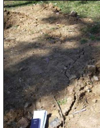
**Figuras 27 e 28** – Área da antiga boca da Mina 11, de propriedade da massa falida da Carbonífera Barro Branco, lacrada pela Ibramil durante a fase operacional da Mina do Campo. Após a execução de obras de melhorias a pedido do superficiário, observou-se o aparecimento de acomodações e rachaduras do terreno.
