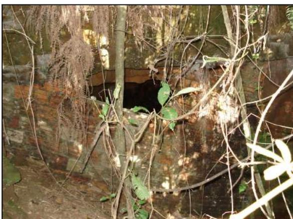
**Figura 82** – Boca de mina situada à jusante da área da Mina do Pilar. Observa-se o tamponamento feito de forma inadequada, já rompido.
