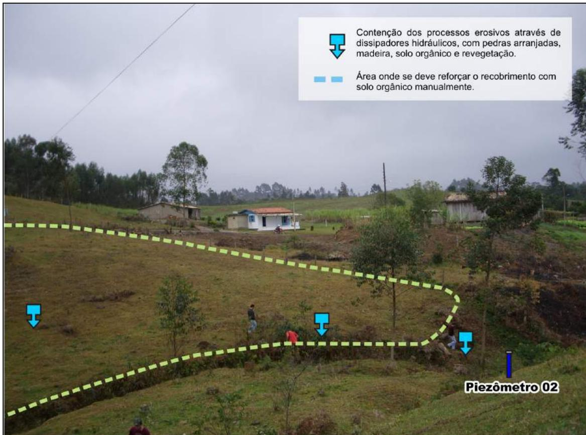
Figura 44 – Esquema de instalação dos piezômetros e recomendações na área da antiga mina do Pilar.
